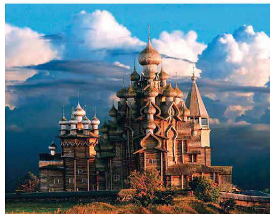
Lesena cerkev na otoku Kiži (17. stol.) je bila zgrajena brez enega samega žeblja!
